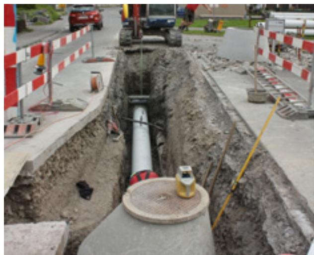
PP-Rohre DN 400, Di 372.6, SN 16 mit Kontrollschacht aus ZR-Fertigteilen U-Grabenprofil (ungespriest) im Strassenbereich
