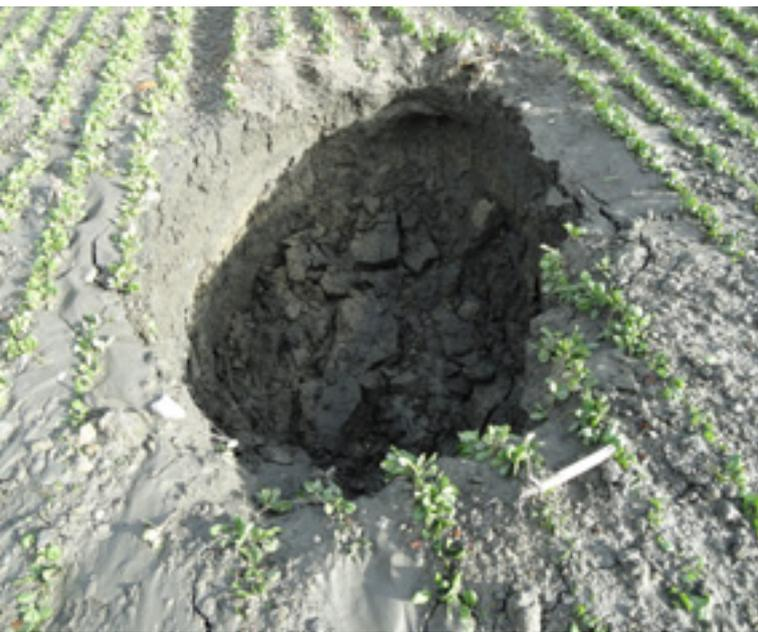
«Einsackung» bei Defekt an alter Verbindungsleitung Montlingen-Kriessern (Jahrgang 1906) in kiesigem und daher stark durchlässigem Untergrund
