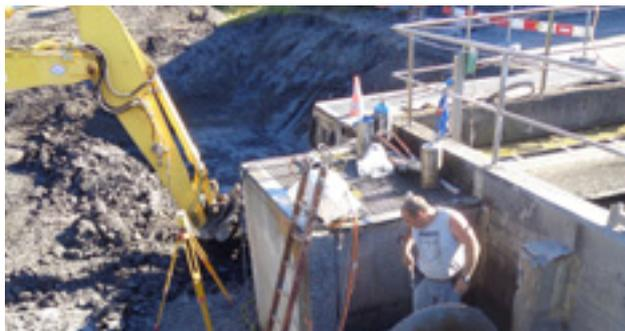
Entfernen von bestehenden Bauten beim Voraushub mittels Betonfräse
