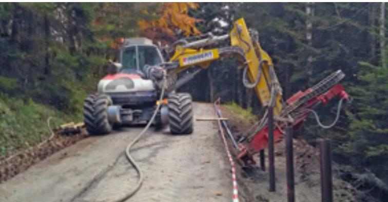
Stabilisierungsarbeiten im Bereich «Kurzstück» mittels «Ribbertverbau» mit Vertikal- und Horizontalanker
