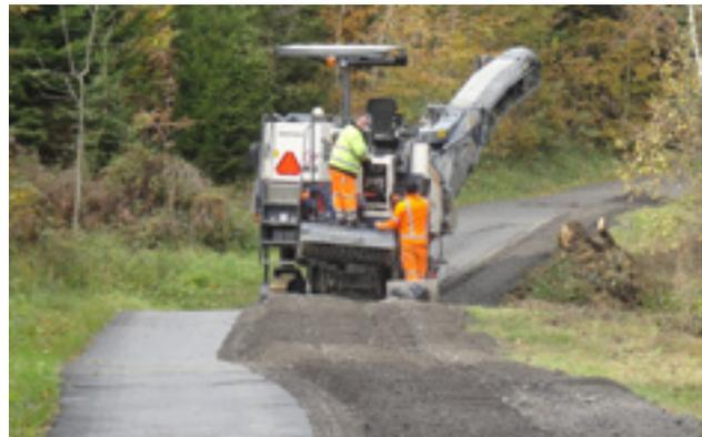
Vorbereitungsarbeiten (Belag fräsen) für Belagsneubau Senkung «Kaminbühl»
