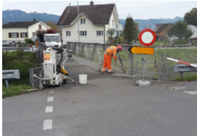
*Brücke Edenstrasse über Rheintaler Binnenkanal (RBK): Vorbereitungsarbeiten für punktuelle Erneuerung Korrosionsschutz an Fachwerkbrücke*
