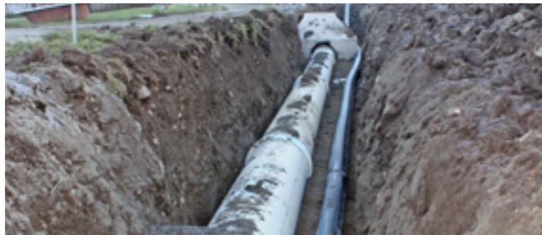
Entwässerung Hard / PP-Rohre für Meteorwasser
