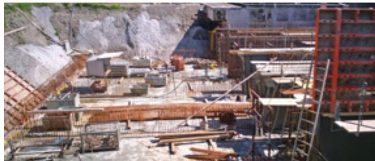
Armierung und Schalung für Aussen- und Zwischenwände bei Beckenerweiterung
