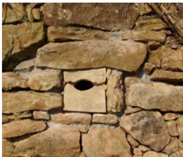
Nisthöhleneinbau in Trockenmauer z.B. bei neuen Rebflächen
