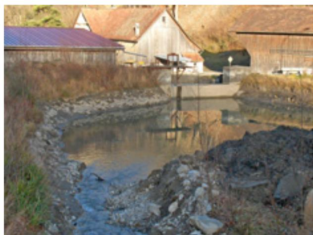
Absenkung des Wasserspiegels und Lagerung des Sammler-materials zur Entwässerung vor Ort
