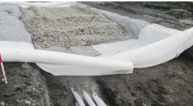
Grobschotter 30/120 umhüllt mit Geogitter auf Geotextil als Trennschicht
