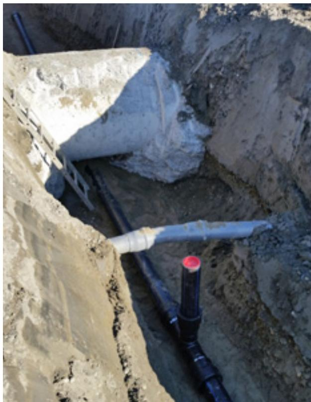
Letzaustrasse Montlingen: Unterquerung der Meteorwasserleitung mit Anschluss (zur Entlüftung) für einen Hydranten
