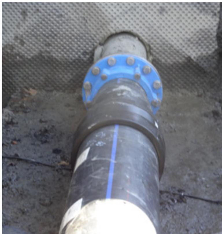
Anschluss mit PE 300 an Austauschstation Oberriet-Widnau
