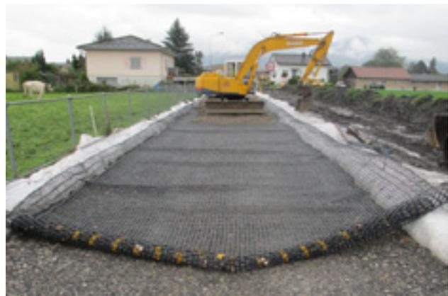
Geogitter als «Armierung» zwischen der Fundationsschicht
