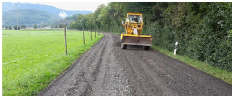
Erstellen der Rohplanie mit bestehendem Fräsmaterial
