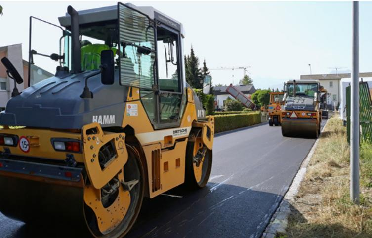
Verdichten des neuen Deckbelags AC 11 N (3.5cm stark)
