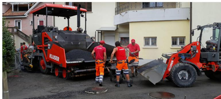
Einbringen der Tragdeckschicht AC T 16N (8 cm stark) auf das neue Kiesgemisch (50 cm Koffer 0/45, 5 cm Planie 0/16)
