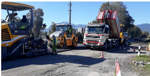
Einbringen der Tragschicht AC T 22 N (8 cm stark) auf die Reinplanie
