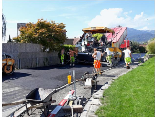
Einbringen des neuen Deckbelags AC 11 N (3.5cm stark)
