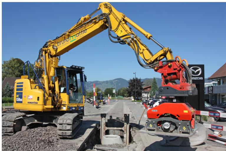
Verdichten der Grabenauffüllung im Strassenbereich mit Spezialanbaugerät am Hydraulikbagger
