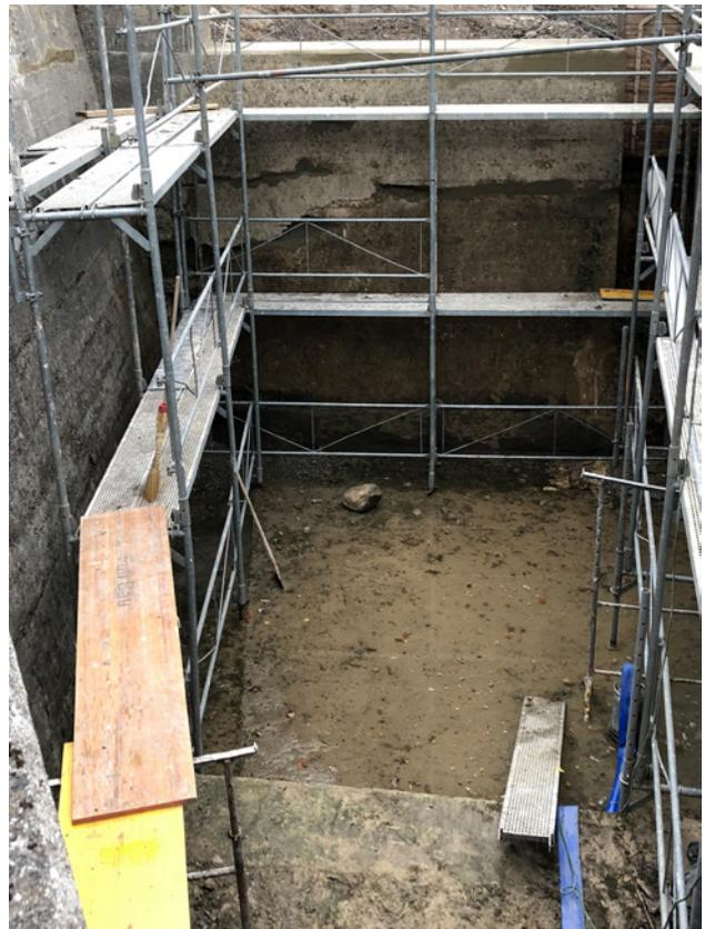
Einbau der Gerüstung für die Betonmauer-Sanierung beim Auslaufbauwerk
