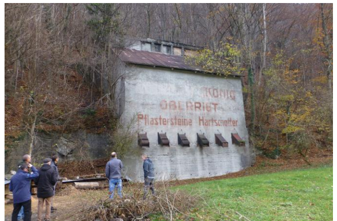
Abb. 17: ehemalige Abfüllanlage Parz. 631 (29.11.2018)
