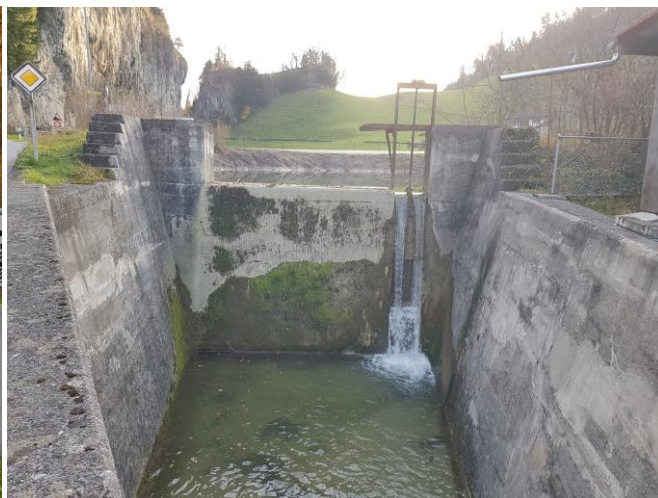
Abb. 19: Staumauer und Tosbecken
