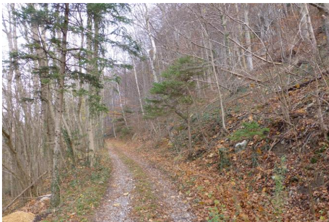
Abb. 16: Bestehende Erschliessung Strasse im Rehag
