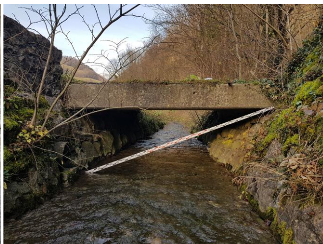
Abb. 21: Brücke Strasse im Rehag
