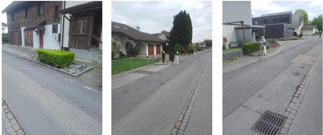
Abbildung 4: Fotos von bestehenden seitlichen Einengungen
