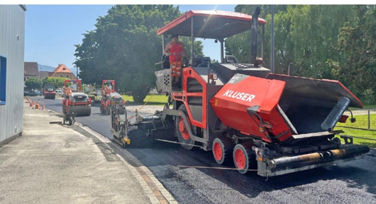
Deckbelagsarbeiten Spechtweg Oberriet
