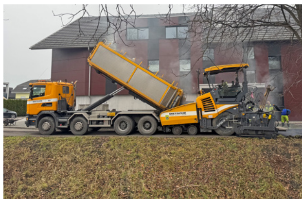
Belagsarbeiten Kanalstrasse Kriessern
