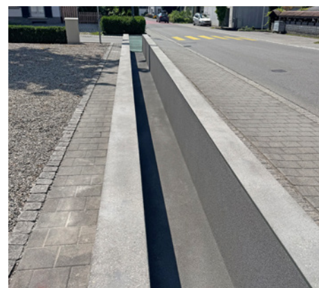
Sanierung Dorfbrunnen Kriessern
