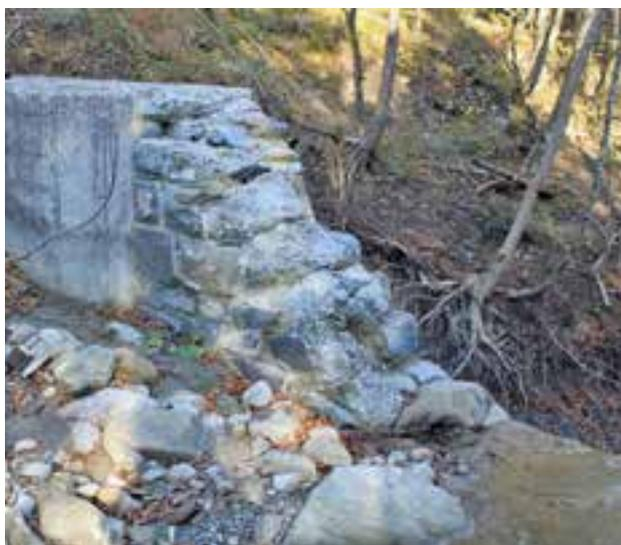
*Dürrenbach: Defekte Sperre am Galgenbach. Diese Schäden sollen im Jahr 2014 instandgestellt werden.*
