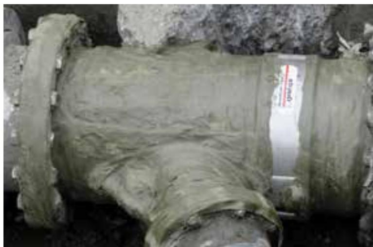
Behobener Schaden mit Straub-Dichtungsschelle
