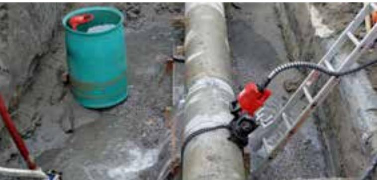
Aufsägen Faserzementtransportleitung Ø 350 mm für Einbau Anschlussgarnitur
