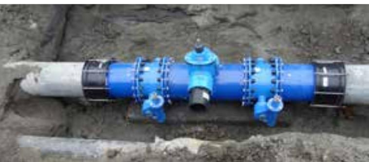
Faserzementtransportleitung Ø 350 mm Anschlussgarnitur eingebaut
